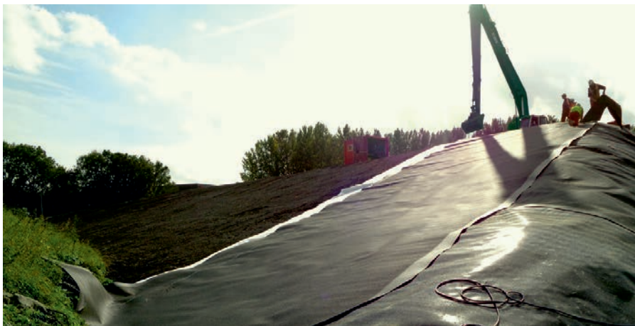
Foto: Overzicht aanleg IBC-werk.
