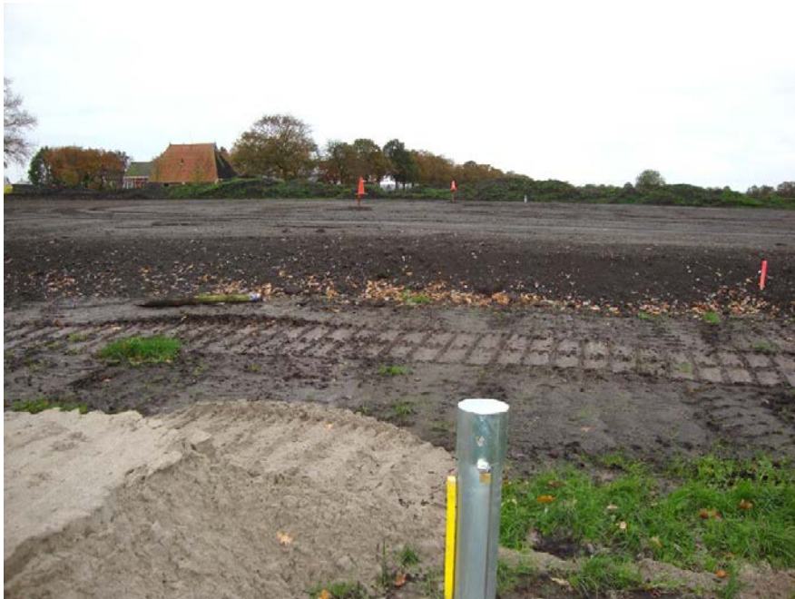
Foto: Bij 20: Monitoringsvoorziening: aanbrengen peilbuis.
