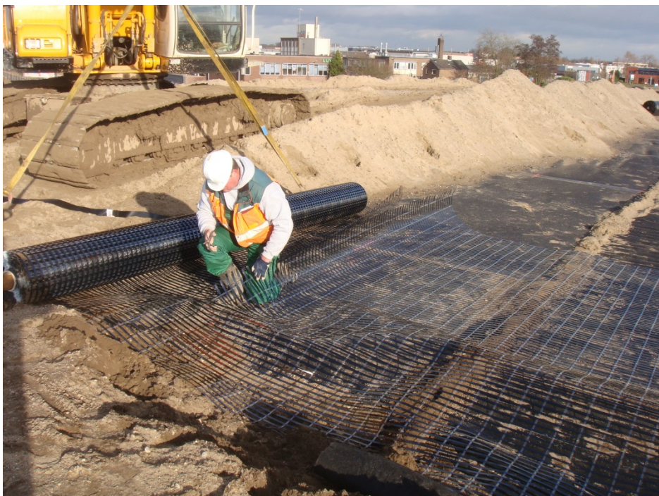
Foto: Bij 8.2 en 8.3: Aanbrengen geogrids.
