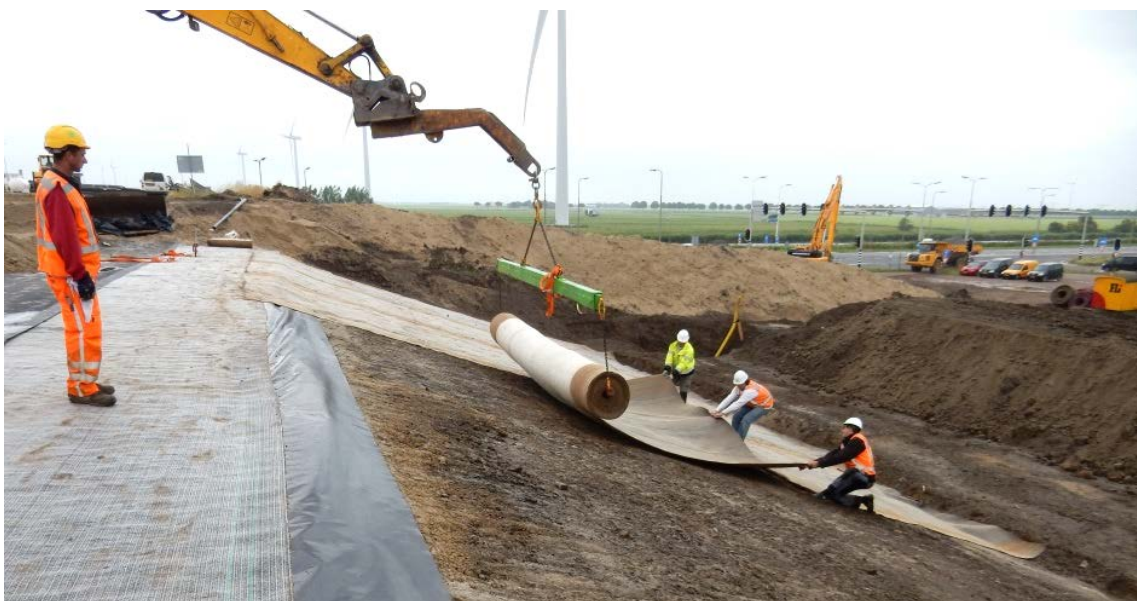
Foto: Toepassing bentonietmat.
