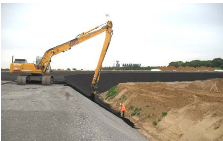
Foto: Aanleg van zandbentonietpolymeergel.
