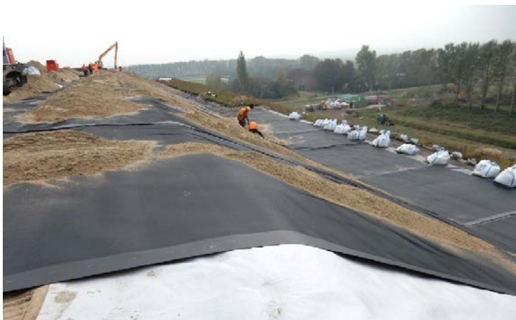
Foto: Aanbrengen geotextiel en HDPE-folie.
