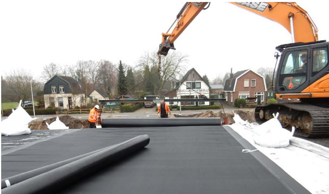
Foto: Aanbrengen HDPE-folie.
